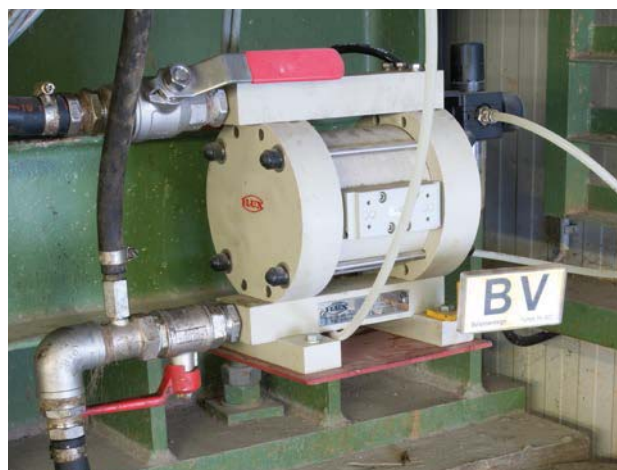
RFM – Закачивание добавок к бетонной смеси из Еврокуба в башенный смеситель
